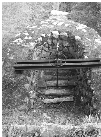
写真-4 南蛮樋門
