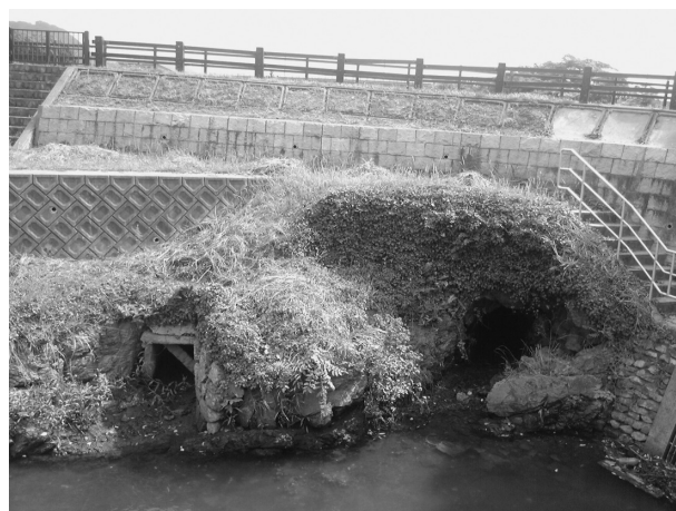
写真-6 樋門の上流側
