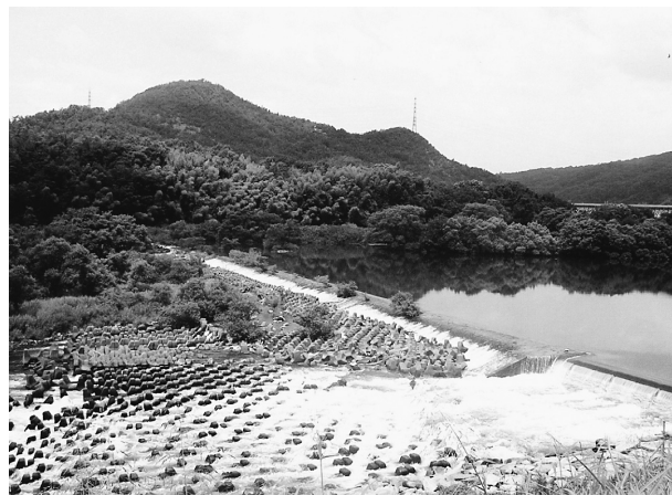
写真-1 笠井堰全景 1)
