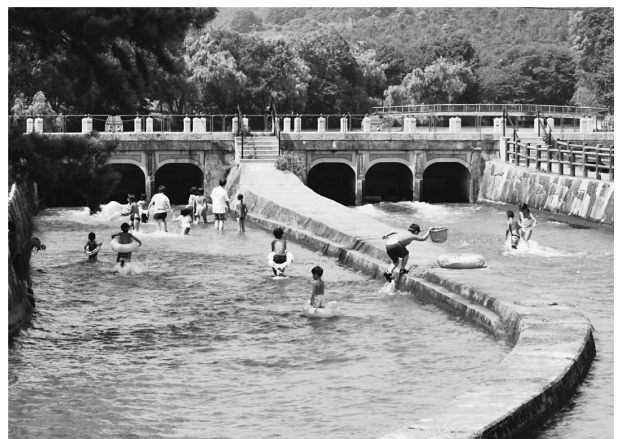
写真-4 夏の南配水樋門
