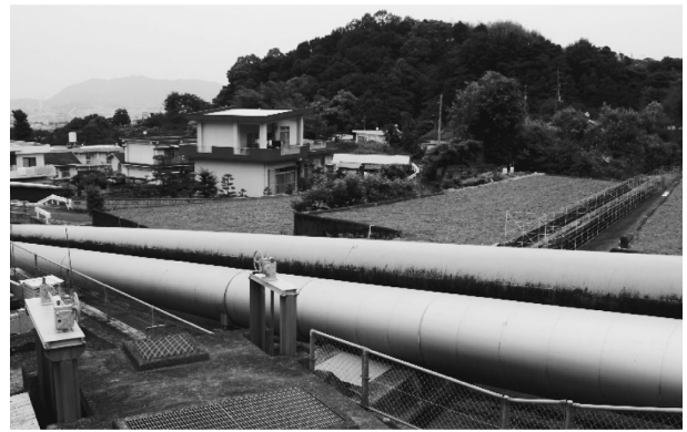
写真-2 東西分水工（手前樋門）と発電用管水路と右上に東部幹線水路
