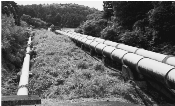
写真-1 疏水分水工から見た法皇トンネルから出た調整水槽から下る用水管（左：農業用水，右：発電・上工業用水）
