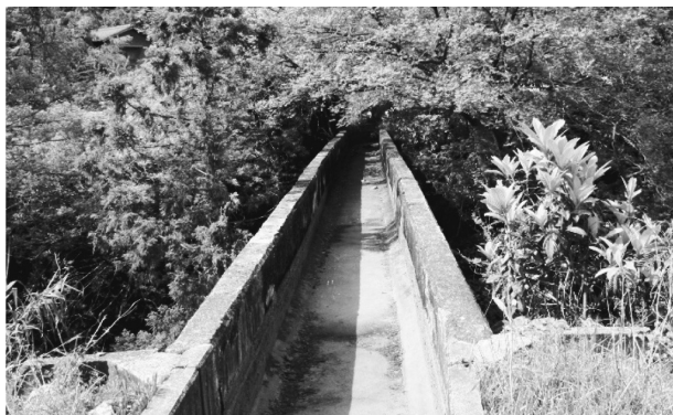
写真-3 琵琶谷川水路橋上部
