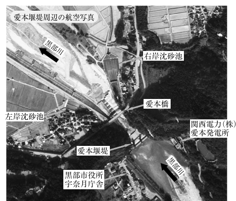
写真-4 愛本堰堤周辺写真
