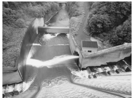
写真-4 堤体から見下ろす
