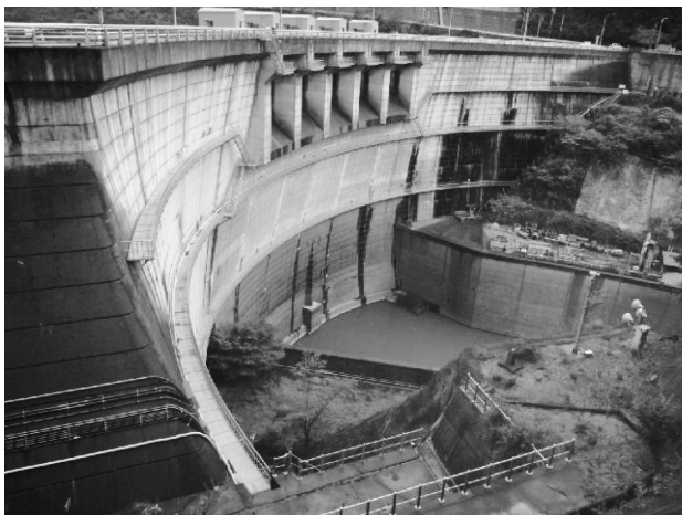
写真-2 大迫ダムの堤体下流面
