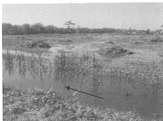
写真-1 地盤沈下により冠水した水田(手前の中田川)
