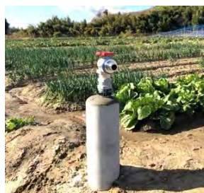
金属製給水栓との接続
