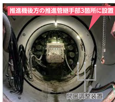
開口調整装置設置状況
