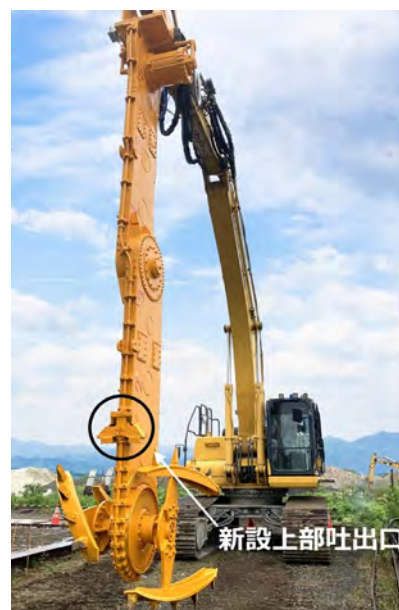
WILL-m工法施工機械全景
