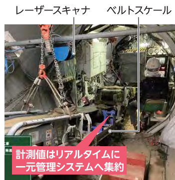
排土量計測状況
