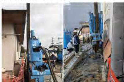
民家際での近接施工
