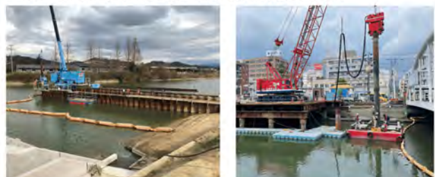
ため池・河川堤防での施工
