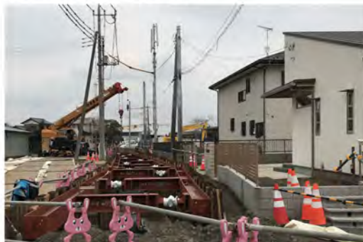
構造物際での施工
