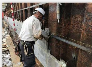
③プレキャストパネル組立 (スタパパネル設置組立)
