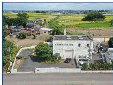
MC防水壁／栃木
