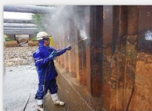
①素地調整工 (高圧洗浄：14.7MPa)
