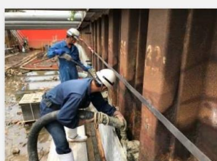
④裏込めコンクリート打設
