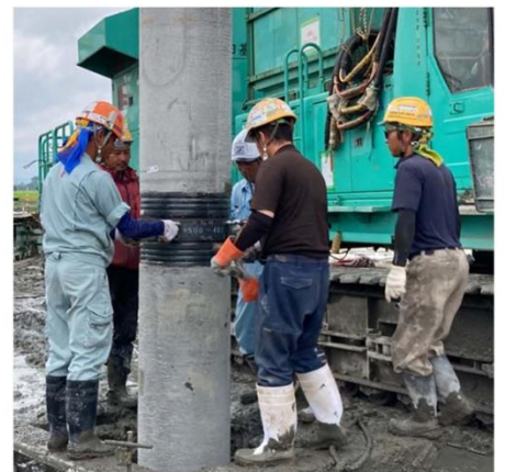
機械式継手の施工状況
