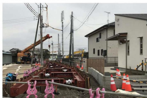
構造物際での施工
