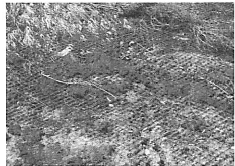
(a) 施工後2年経過
