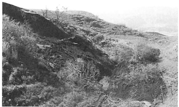
図2 震災直後の草地の被災状況
