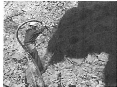
図1 基盤材の吹付けの状況
