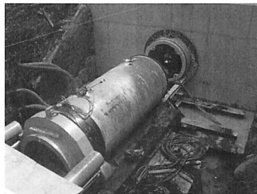
写真2 発進坑口における施工状況
