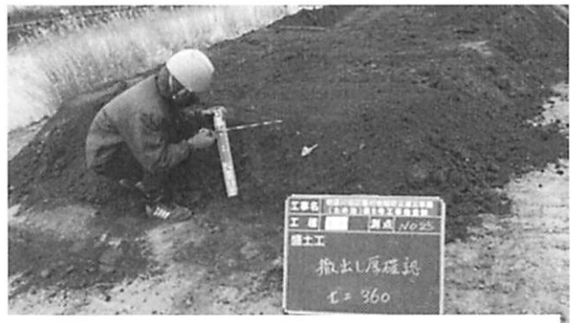
写真④：巻出し厚の現地確認 (t=36cm)
