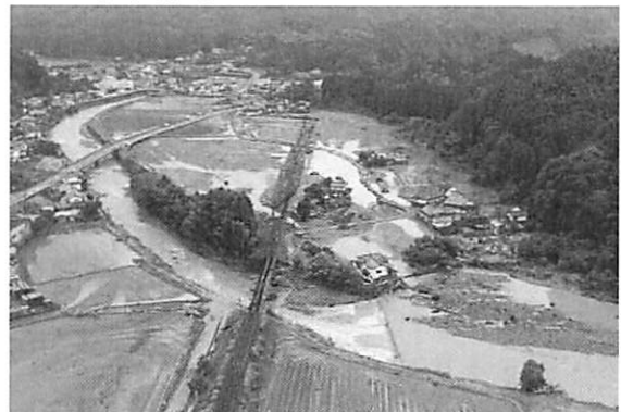
図 2 大肥地区被災状況(平成 29 年 7 月 7 日撮影)
