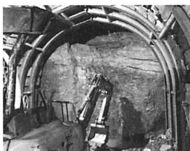
写真-4 導水完了
