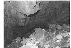
図5 隧道空洞化
