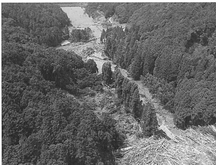
三反田ため池（土砂・流木流入）
