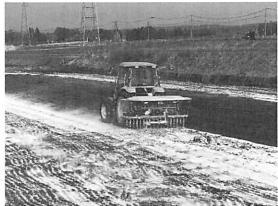
写真 3 中和剤散布状況
