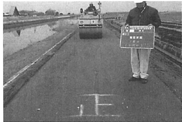
写真⑤：転圧回数の現地確認 (5回目)
