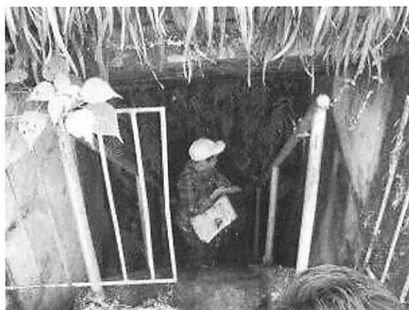
写真3 源ヶ鼻隧道管理坑
