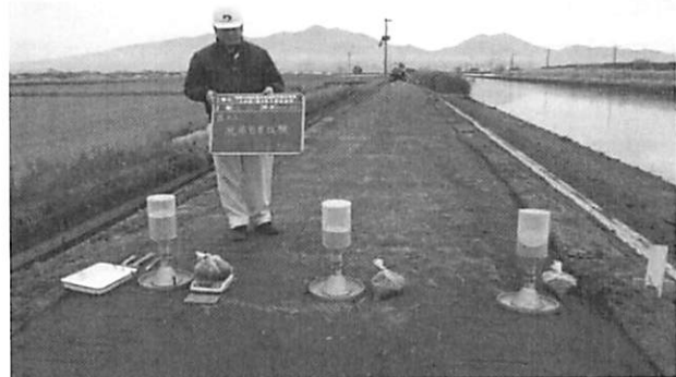
写真⑥：現場密度試験状況
