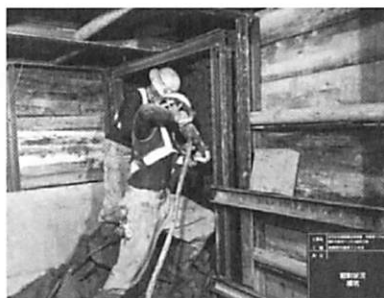
写真-3 導水迂回坑掘削状況
