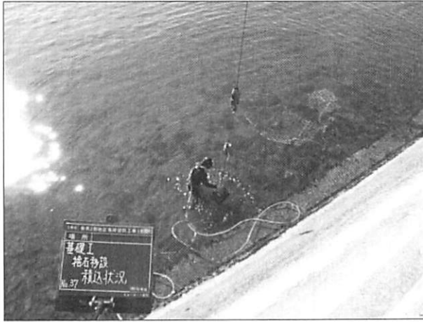
人力による減採石の積込
