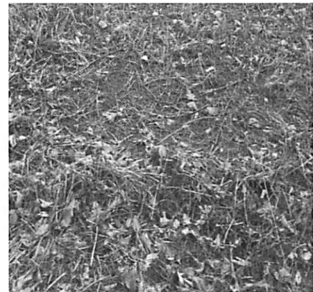
図9 竹繊維吹付工における3年経過後の基盤材の状況
