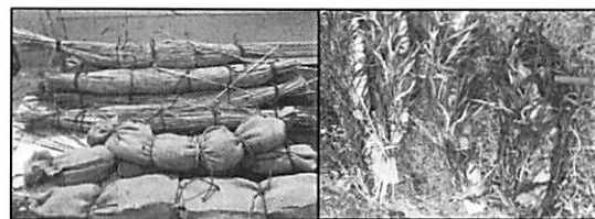
写真-3 移植床(左)にヒラモを設置した様子
