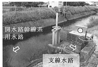
図-2 開水路幹線系用水路から分岐する支線水路
