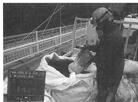
写真-2 ケレンかす回収状況
