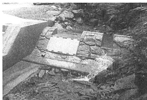
写真1 化粧型枠を利用した取水堰
