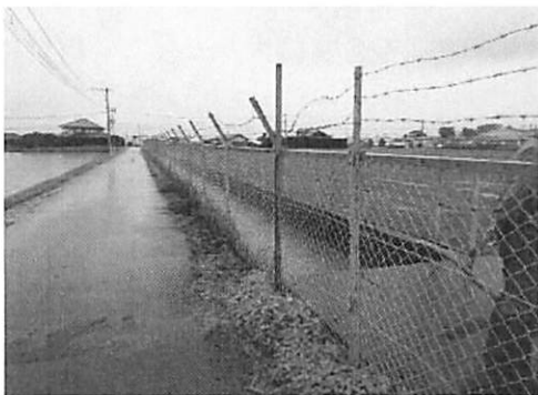
写真1: 除塵機下流の状況
