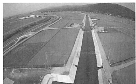
写真-7 護岸復旧後の藻川
