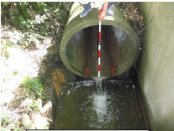
写真1 底樋漏水状況
