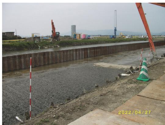
Fig.1 半川締切工法による施工状況
