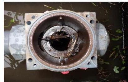
写真1 給水栓弁体部のゴミ詰まり状況
