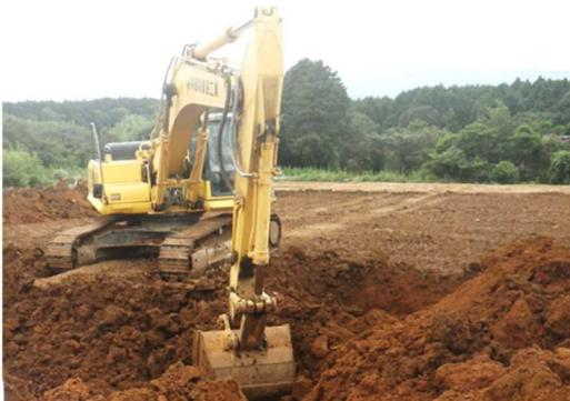
写真4 混層耕施工状況
