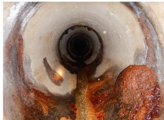
写真2 底樋継手漏水状況
