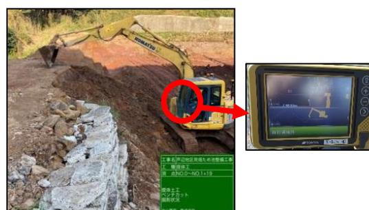
図5. ICT建設機械による掘削状況
