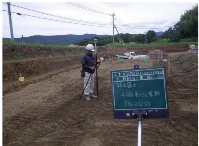
写真-3 移動極を用いて地盤高を確認
