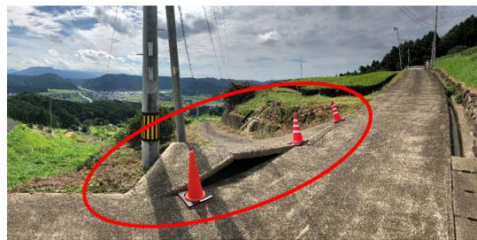
写真-2 農道舗装路面の破損（末端）
