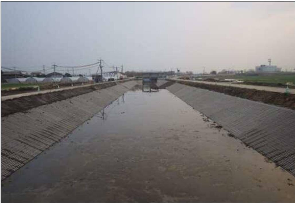
写真-1 ブロックマット工による法面保護工の完成状況
