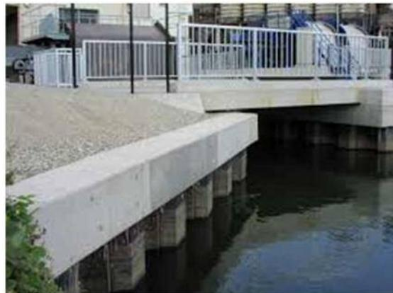
写真-2 鋼矢板護岸工(他地区事例)
