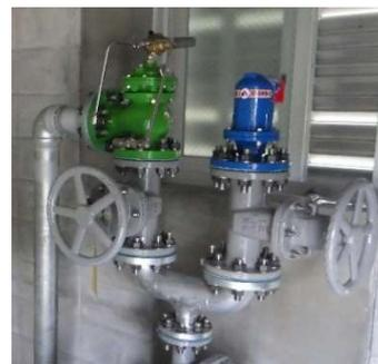
写真2. 安全弁設置状況
