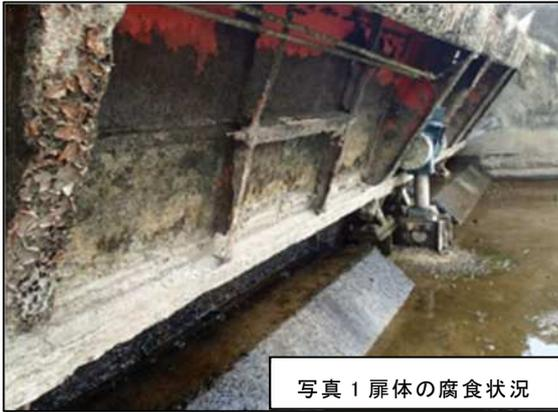
写真1 扉体の腐食状況
