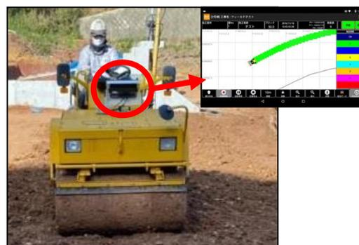
図6. ICT建設機械による締固め状況
