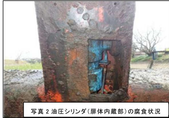
写真2 油圧シリンダ(扉体内蔵部)の腐食状況
