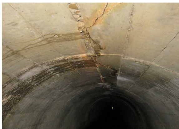
【水路トンネル】
