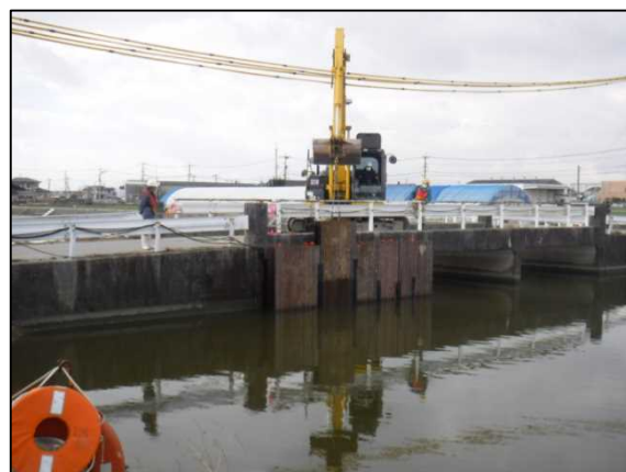
写真5：仮設ゲート引き抜きの様子
