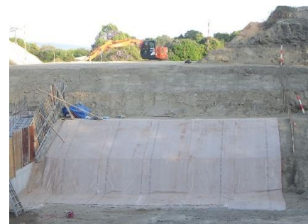
写真.1 遮水シート設置
