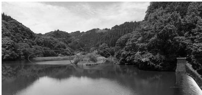
写真③: 堆砂が進行して湖面に出現した“島”
