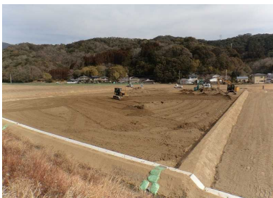
施工状況写真（整地工）
