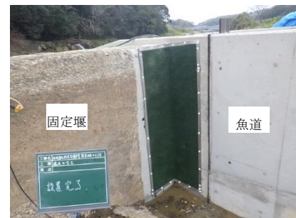
写真-5 遮水シート工状況
