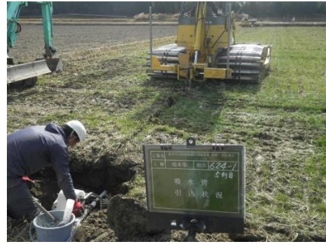
写真-5 シートパイプ施工(引込作業)
