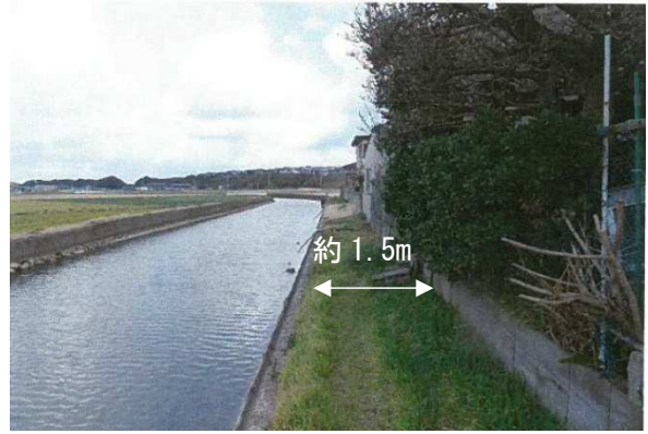
図 2 1 工区 (左岸) 近景
