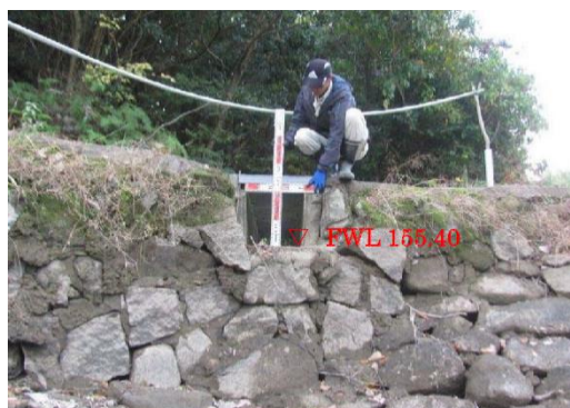
写真-2 既設洪水吐の状況
