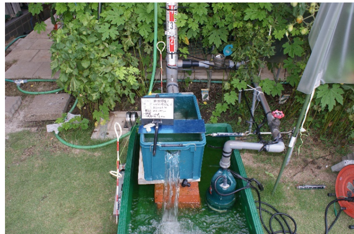
写真-1 三角堰流量測定装置
