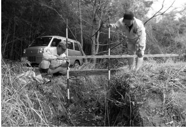
写真3 掘削前の洪水吐（撮影：2019年）
