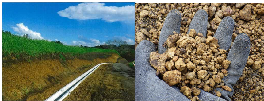
写真 1 ボラ土法面・土質接写
