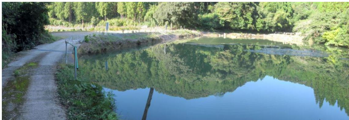
写真-1 鹿丸ため池上流から堤体を望む(左の鋼製蓋水路が現在の洪水吐)
