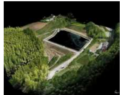
図3 点群データ(UAVレーザー)
