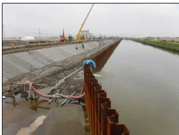
写真3：施工状況（半川締切）
