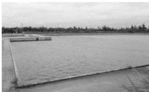
写真2. 多良間村の既設集水池
