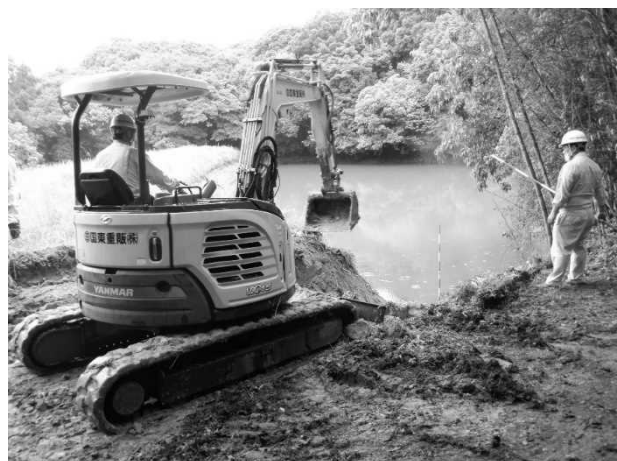
写真6 洪水吐掘削の様子（撮影：2020年7月12日）
