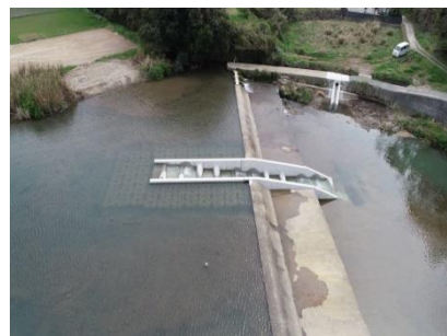
写真-6 完成状況
