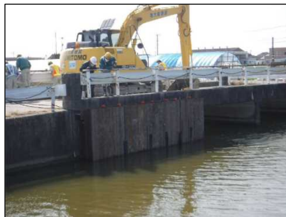
写真4：仮設ゲート（H形鋼を加工）
