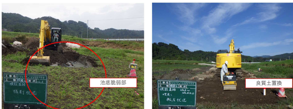
写真 2-4.池敷内の工事用道路施工状況
