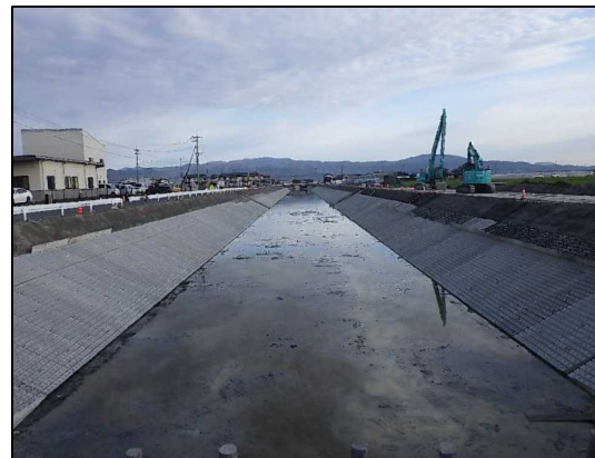
写真2：通水前の状況(千代田線)
