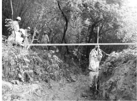
写真4 掘削後の洪水吐（撮影：2020年7月12日）
