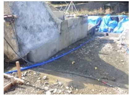
写真-3 間詰め Co 打設後
