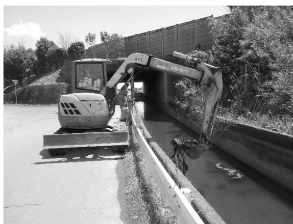
図4 重機による用水路の土砂上げ
