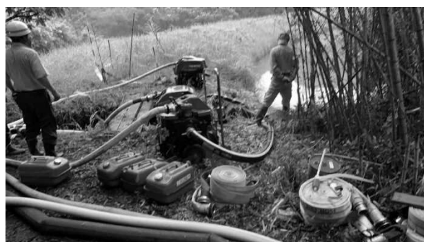
写真2 ポンプ排水の様子（撮影：2020年7月11日）
