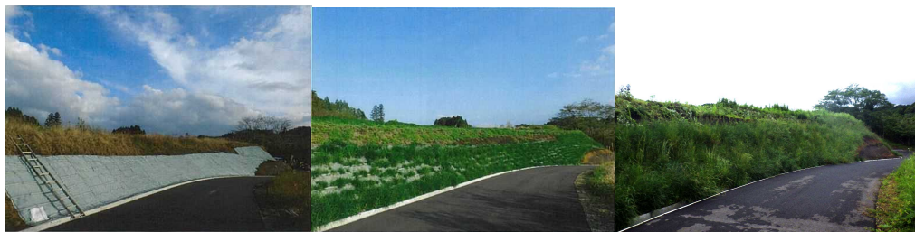
写真 2 キルケット M2 施工後の状況(施工直後→3 ヶ月半後→5 ヶ月後)
