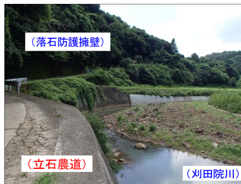
写-1 終点側から撮影
