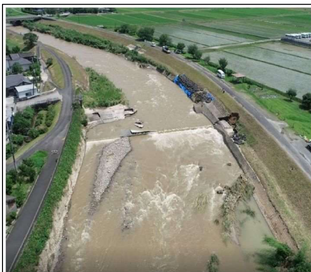
被災状況（令和2年7月8日撮影） （国土交通省 遠賀川河川事務所より提供）
