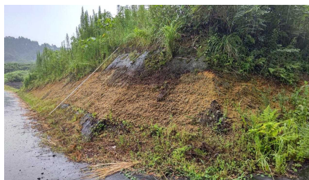
写真 3 無処理法面(令和 2 年 2 月土工事完了)
