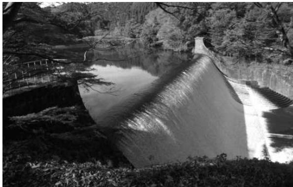
写真①: 右岸側から堰堤を望む
