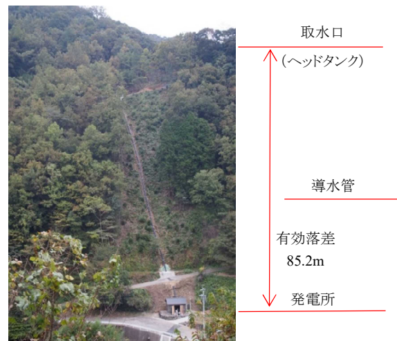
写真 1 大日止昇小水力発電所
