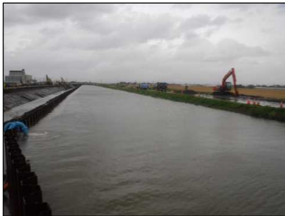
写真 8 : 施工時の状況（水位上昇時）
