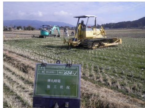
写真-2 弾丸暗渠工
