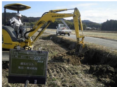
写真-3 ピット掘削
