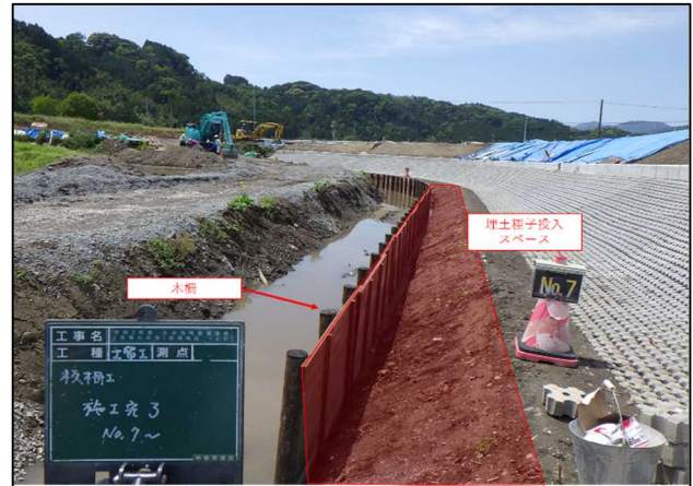
写真 2-5.生育柵施工状況
