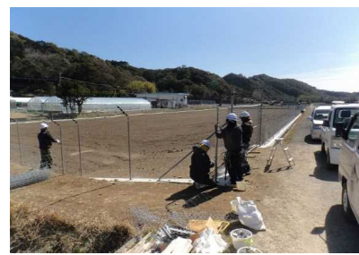
施工状況写真（鳥獣侵入防止柵設置）
