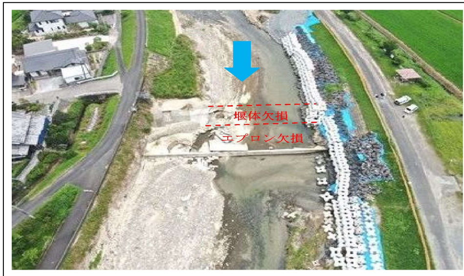
被災状況（上空より撮影）
