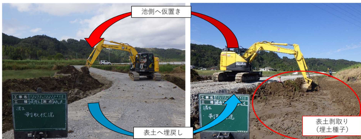
写真 2-3.堤体付近の埋土種子仮置き状況
