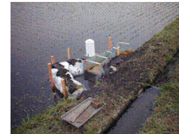
写真-6.2 水口側設置例
