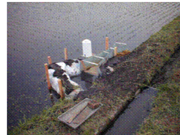
写真-6.2 水口側設置例
