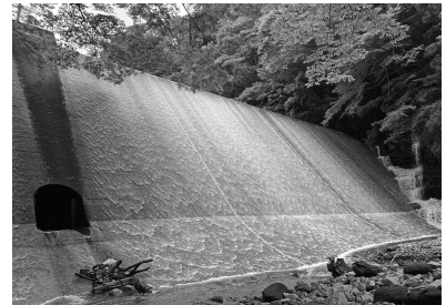
世界農業遺産の棚田を潤す落立堰堤
