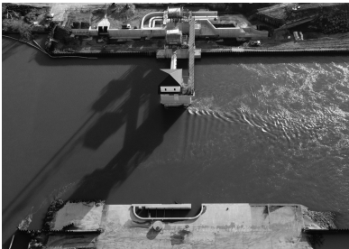
芦野頭首工の改築状況
