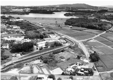
愛知用水幹線水路と東郷調整池
