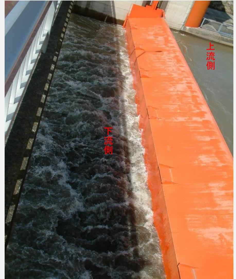
図-16 北空知頭首工右岸側洪水吐3号ゲートにおける堆砂フラッシュ実行中
