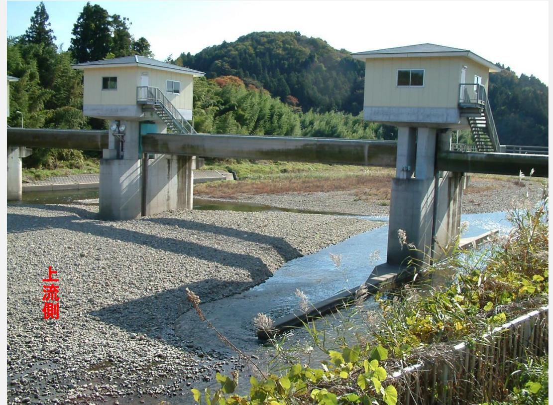
図-14 森田頭首工における可動堰敷上堆砂によるゲート閉鎖不能
