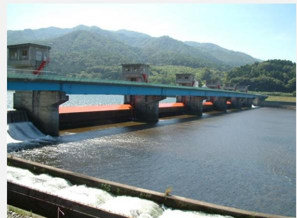
荒川頭首工（全面可動堰, 新潟県羽越荒川）
