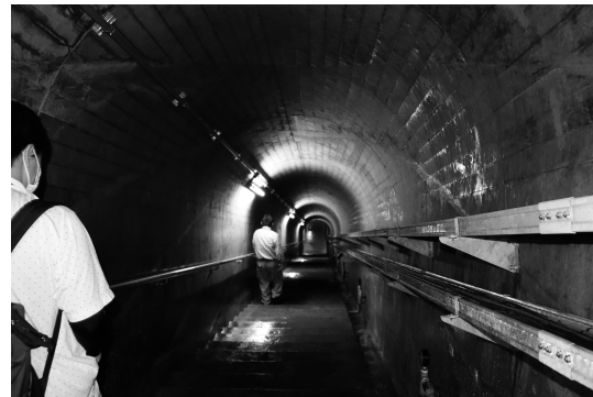
写真-2 佐古ダム監査廊
