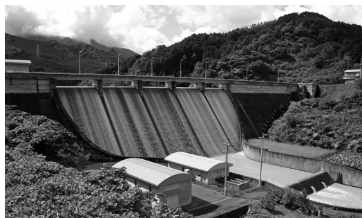
写真-1 佐古ダム全景
