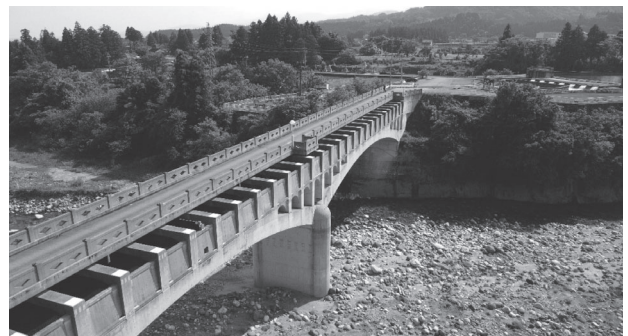
写真-2 左岸連絡水路橋
