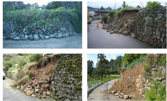
躯体上部が崩れ、石が法尻に溜まる
