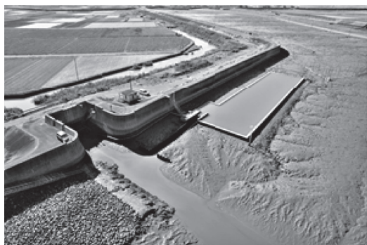
写真-2 タイドプール海水貯留の状況
