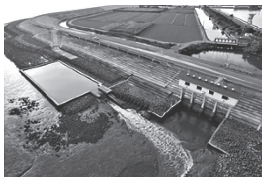
写真-6 大和干拓フラッシュ施設の状況
