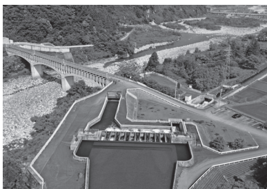
景観に溶け込む兩岸分水工と 左岸連絡水路橋（藤井 修）
