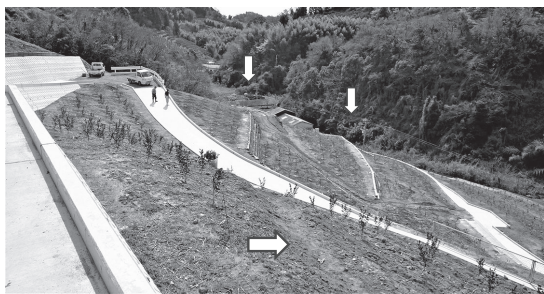
写真-2 復旧された農地 (中腹の承水路兼用農道から)
