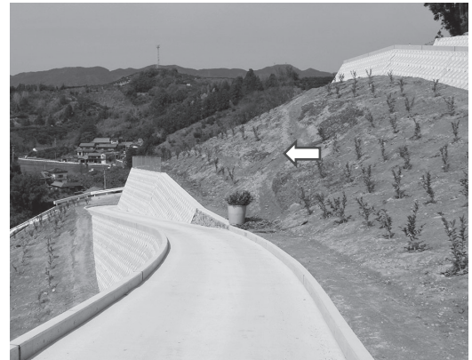
写真-1 承水路兼用農道と植栽する大苗を入れた籠 (写真中央、⇒は作業道)
