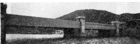
写真-5 長径間ローラーゲート
