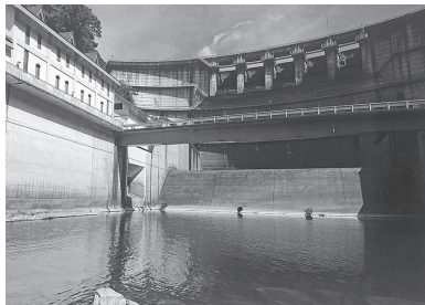
大迫ダム下流側施設管理（点検設備）設置のための調査風景
