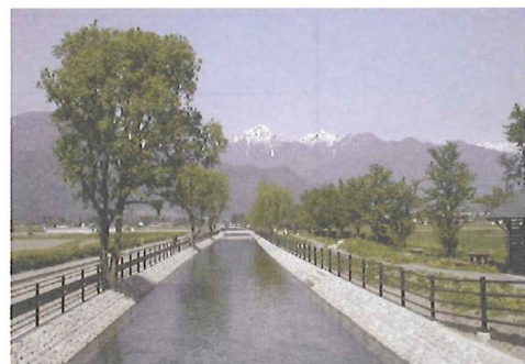
写真-3.3 改修工事後
