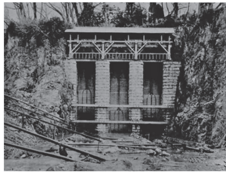
写真-1 竣工間際の大水門（明治34（1901）年5月）
