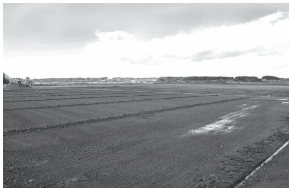
写真-1 農地の区画整備工事の様子(茨城町)
