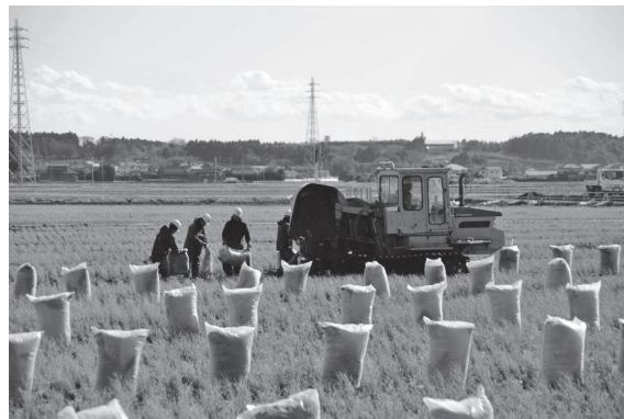
写真-2 トレンチャによる暗渠施工の様子
