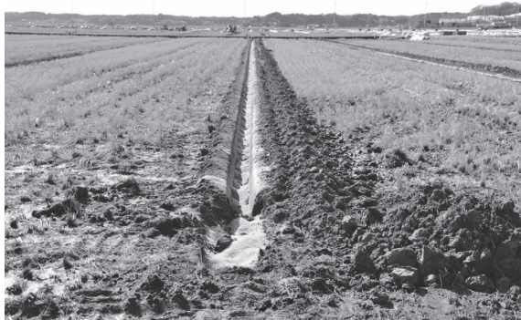
写真-4 暗渠施工後の様子
