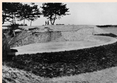
洪水吐（改修後）
