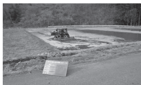
写真-4 除塩対策実施状況(耕起後攪拌)
