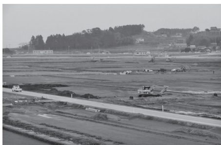
写真-6 圃場整備施工状況（陸前高田市小友工区）
