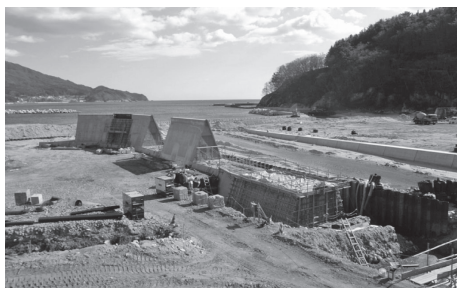
写真-8 農地海岸保全施設施工状況（大船渡市吉浜）
