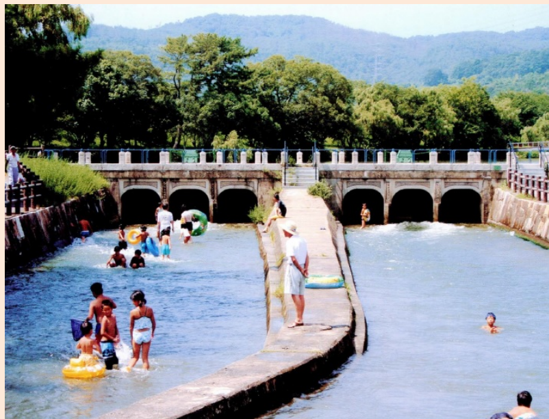
第73巻第8号（2005年）表紙（河原正信氏撮影） 南配水樋門
