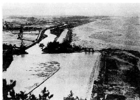
写真-1 当時の常西合口用水路(下流を望む)
