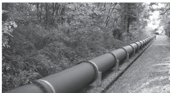
写真-2 現在の御坂サイフォン（下流側管路）
