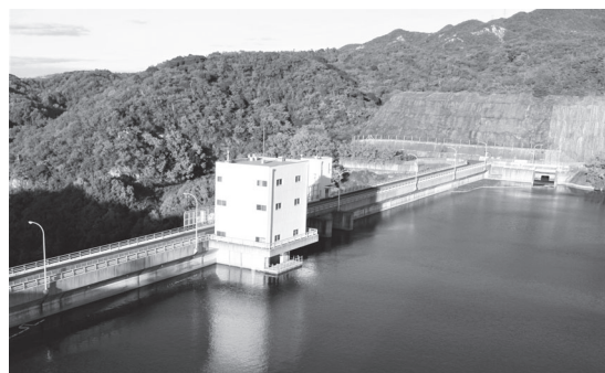
写真-4 統合管理事務所から見た呑吐ダム取水塔
