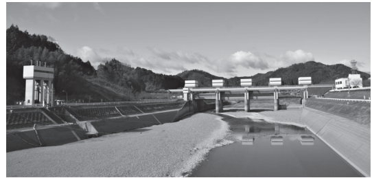
写真-1 川代ダム施設の全景（左に用水取水口、右に管理棟）
