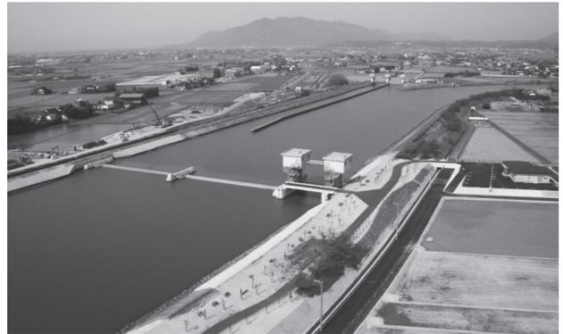
写真-1 平田船川汐止堰（汐止めしている様子）<sup>2)</sup>
