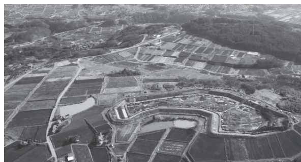
写真-2 区画整理された圃場と工事中のため池(平成 21 年)
