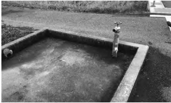
写真-5 明治用水の用水路に設置された洗い場
