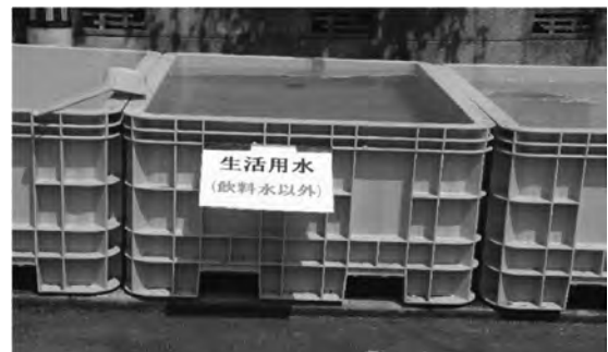
写真-2 生け簀用のタンクを利用した生活用水の供給
