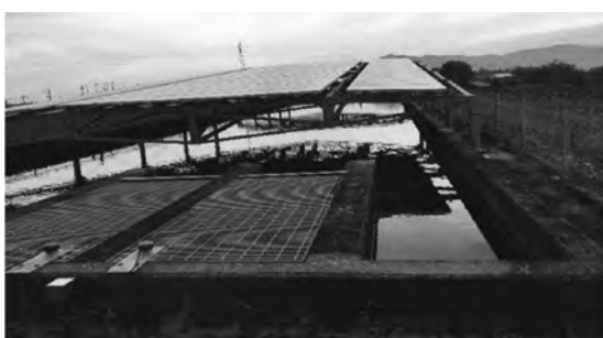
写真-4 ファームポンドに設置された太陽光パネル
