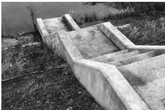
写真-3 ため池へアクセスするための階段
