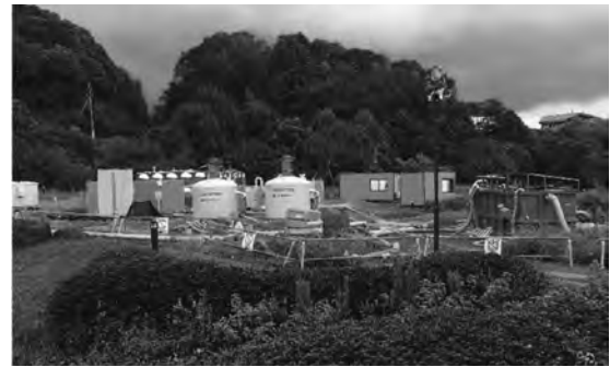
写真-1 仮設の浄水施設
