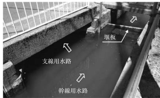
写真-1 堰板の設置による支線用水路への分水操作
