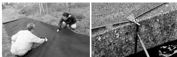
写真-2 遮光ネットの切断、展張，固定方法
