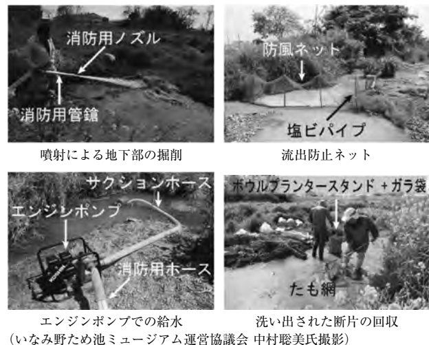
写真-2 ジェット水流による除去作業
