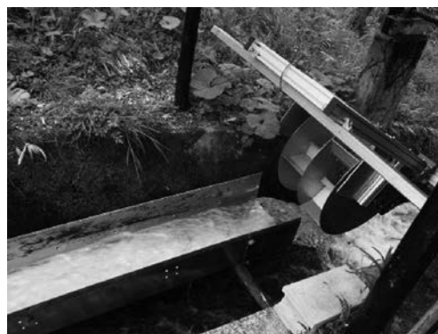
写真-5 水車発電装置への当初の給水状況
