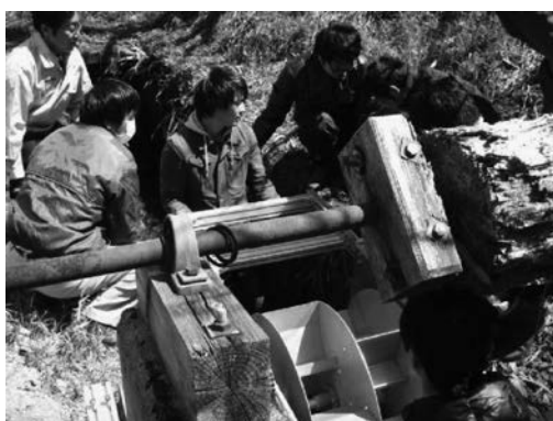
写真-4 水車発電装置の設置状況
