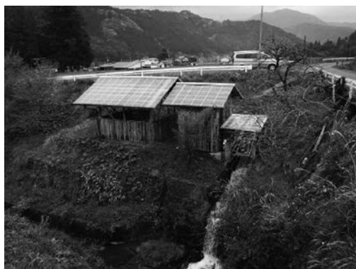
写真-3 水車発電装置の設置位置周辺の状況
