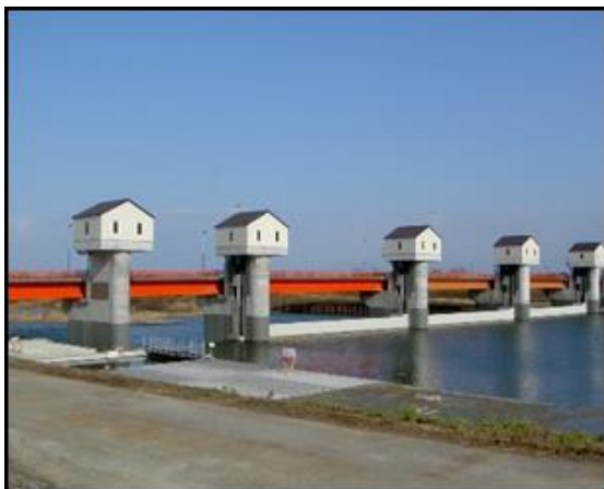
頭首工 (取水堰)
