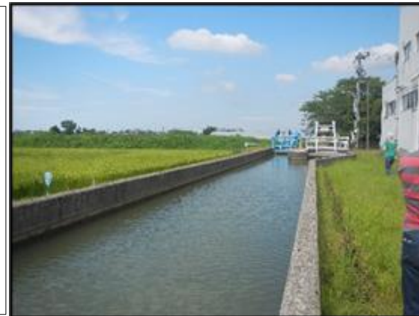
幹線用水路 (開水路)
