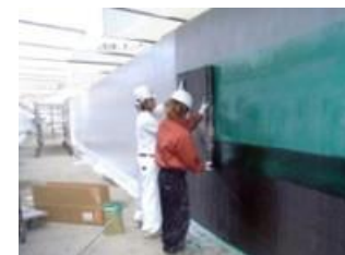
開水路補修補強工法の適用と評価を現地にて実証
