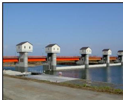
頭首工（取水堰）
