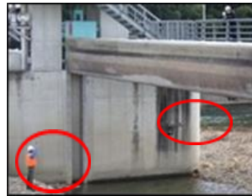
UAVを活用した構造機能調査手法
