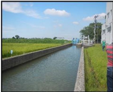
用水路（開水路）
