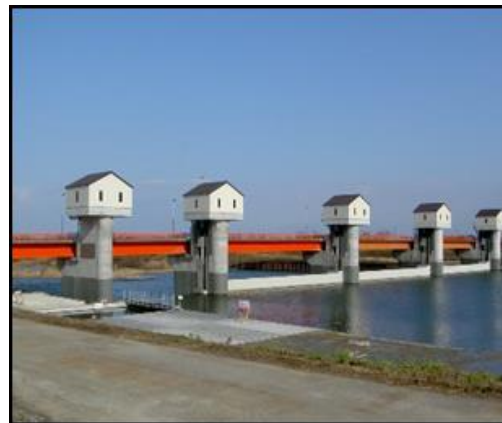
頭首工（取水堰）
