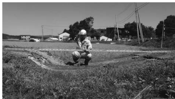
写真-6 厚幌導水路埋設部の地表面の沈下（沈下量約 40 cm）
