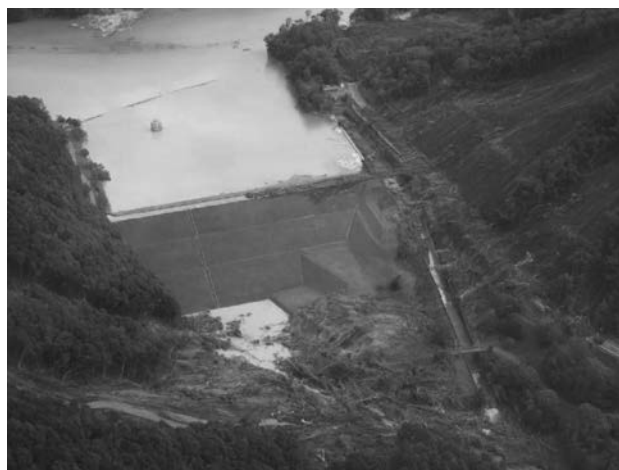
写真-1 発災直後の厚真ダム
