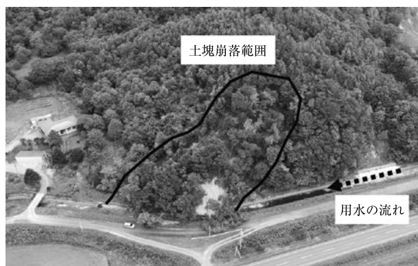
写真-9 地すべりによる用水路の埋塞（川西幹線用水路）
