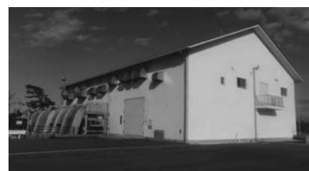
写真-4 本復旧後の二郷堀排水機場
