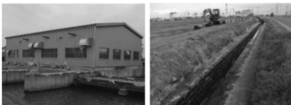
写真-3 緊急応急工事による仮復旧状況 （左：二郷堀排水機場，右：北長沼堀排水路）
