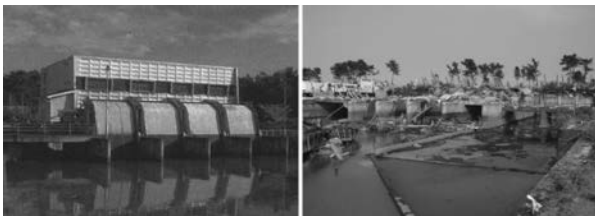
写真-2 二郷堀排水機場（左：被災前、右：被災直後）
