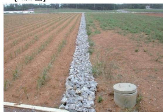
**Fig.6** 耕土流出施設整備における施工例（沖縄総合事務局、不明）
