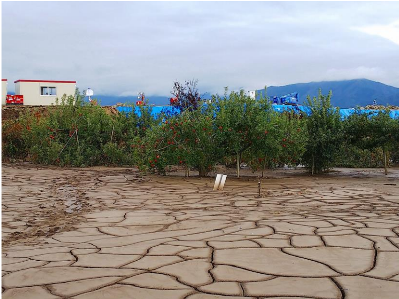
写真8 厚く堆積した土砂は固化し、排除が一層困難になる
