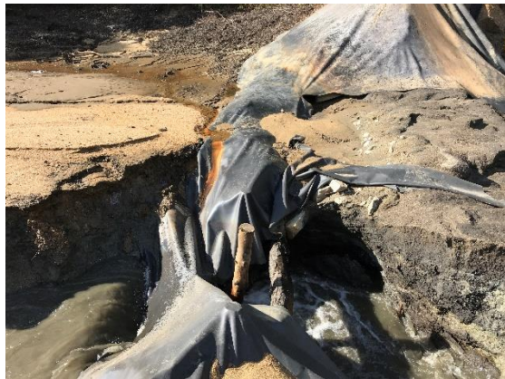
写真2 旧底樋の基礎杭
