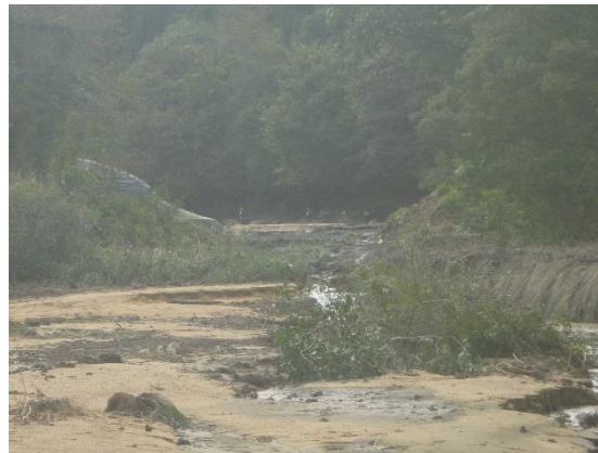
写真4 逆川上ため池の決壊水 および土砂が逆川下ため池に流入
