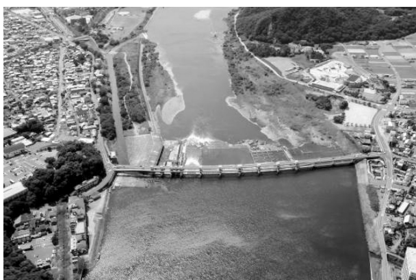
写真-2 改修後の犬山頭首工
