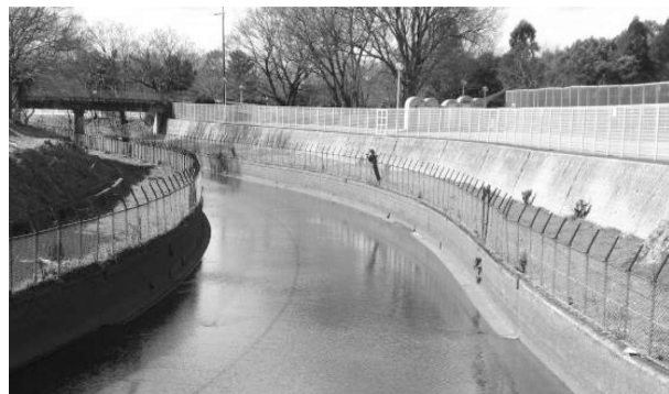
写真-4 改修前の宮田導水路
