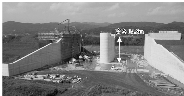
写真-2 水門全景（コンクリート打設状況）
