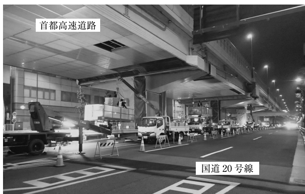
写真-6 施工状況（国道上で作業）
