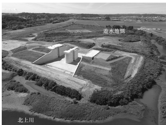
写真-4 水門全景（施工完了）
