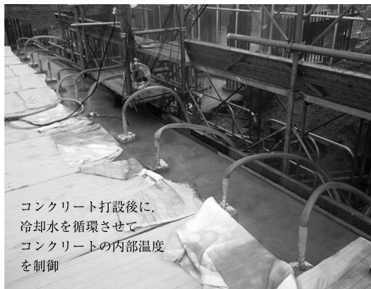
写真-3 パイプクーリング状況
