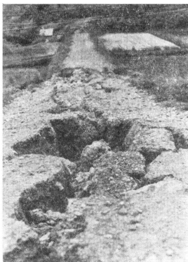
写真-3 農道の破壊
