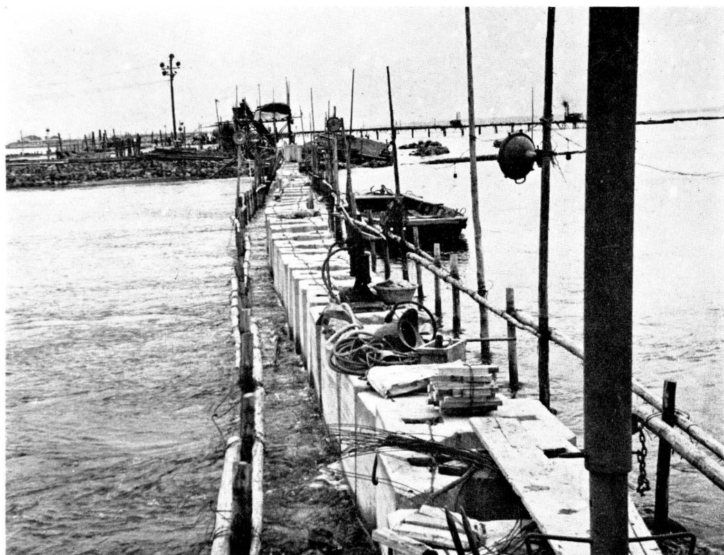
写真二 第 2 潮 止 め 口
