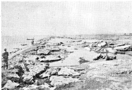
写真—19 城南干拓海岸堤防の破壊状況
