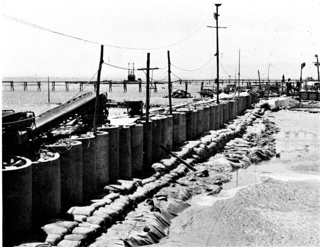
写真一 第 1 潮 止 め 口
