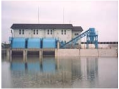
排水機場の整備
