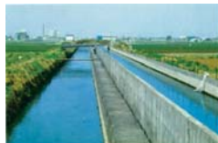
新設された用排水路
