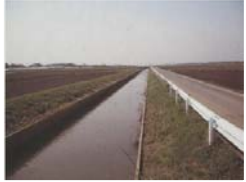
排水路の整備
