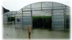
湛水被害を受けるハウス施設
