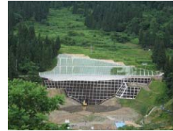
地すべり対策工事の完了
