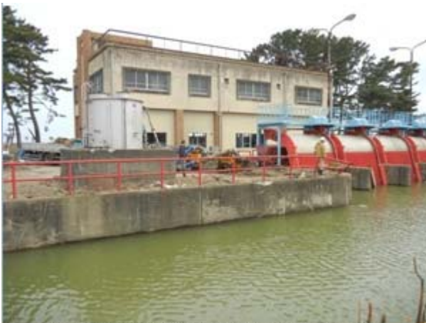
写真10 津波被害を受けた閉上排水機上
