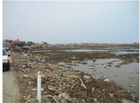
写真9 後方でガレキ除去を行っている
